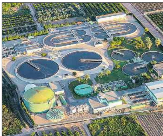
Planta de tratamiento de agua. ISTOCK
