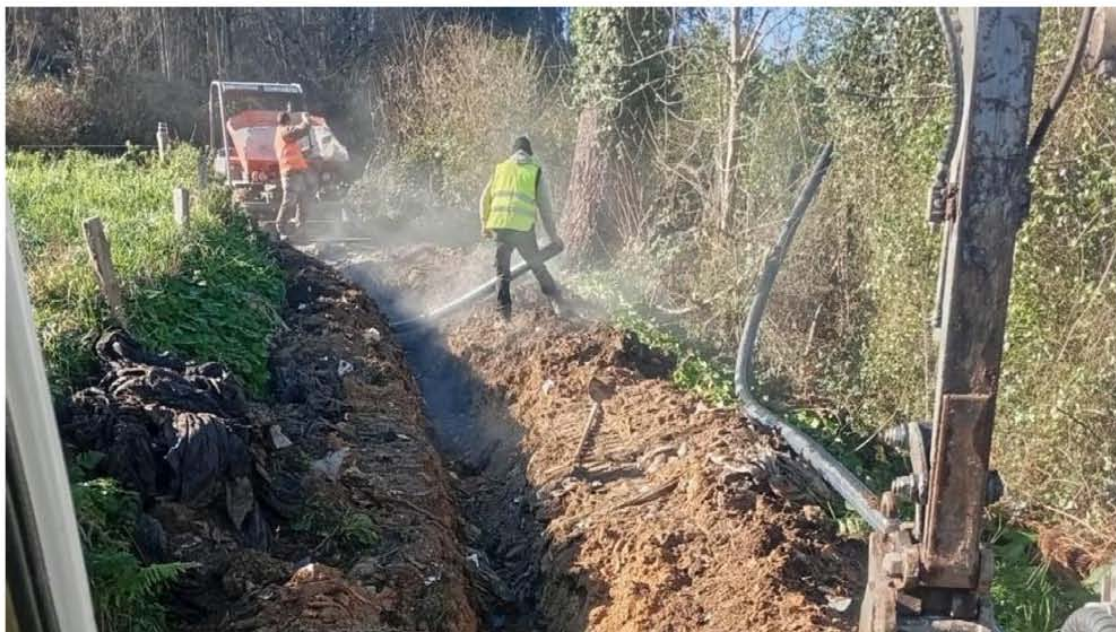
Las obras de saneamiento de San Justo.
