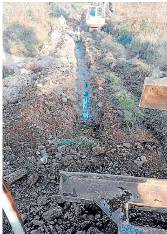
Obras en la zona maliaya de San Justo. E. C.
