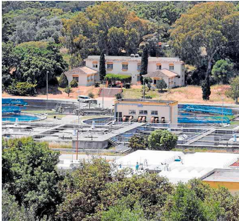
Acosol ha registrado en enero cuatro proyectos para producir biogás en sus depuradoras. JOSELE
