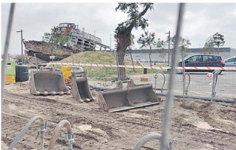
La avenida de la Bajamar es hasta ahora la más afectada por los trabajos.
