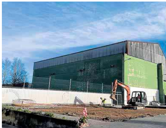
Obras de construcción de la nueva pista de pádel. g. c.
