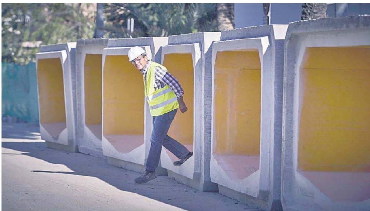
Un imagen de archivo de los grandes marcos que conforman las conducciones para el nuevo tanque de tormentas de La Puntilla.
